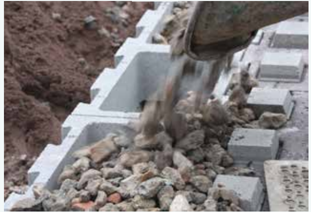
Vullen counterblok met gerecycleerd beton 10/40 zonder zandaandeel.
