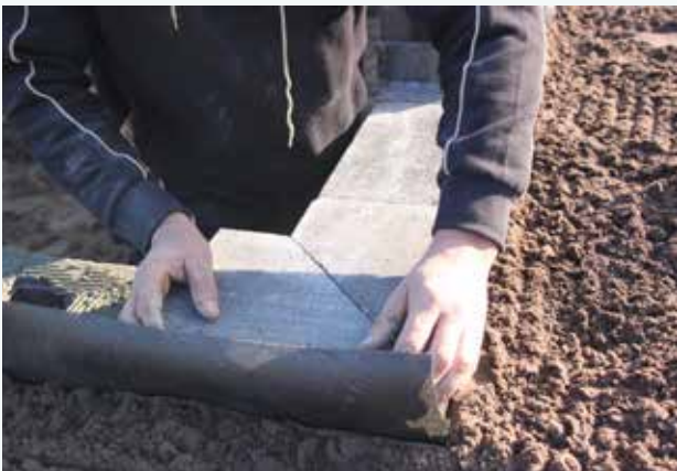
Plaatsen cap met betonlijm (o.a. ominicol BB of Murocol S).
