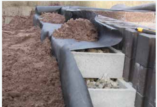
Aanbrengen worteldoek op bovenste counterblokken.
