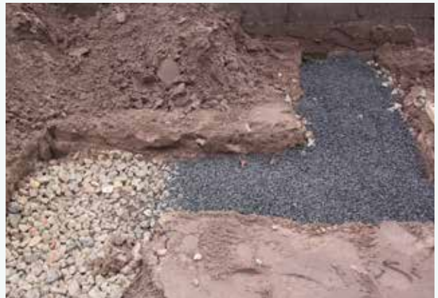
Aanbrengen dun laagje fijne kiezel 2/4 om te egaliseren.
