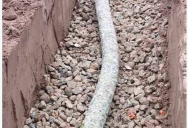
Vullen sleuf met gerecycleerd beton 10/40 tot 20/40 en plaatsen drainagebuis.
