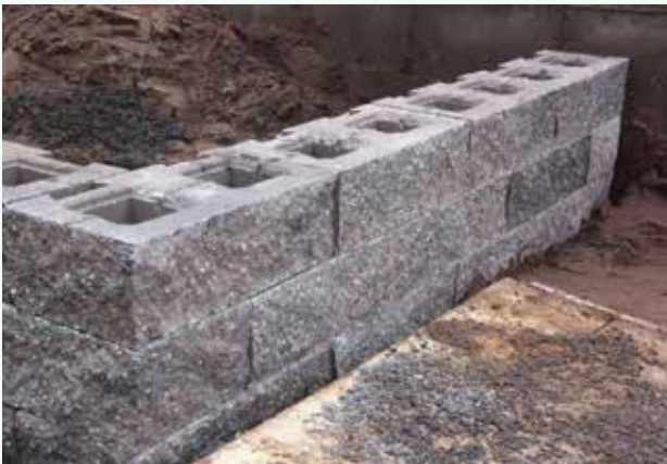
Plaatsen van volgende lagen G-blokken en counterblokken.
