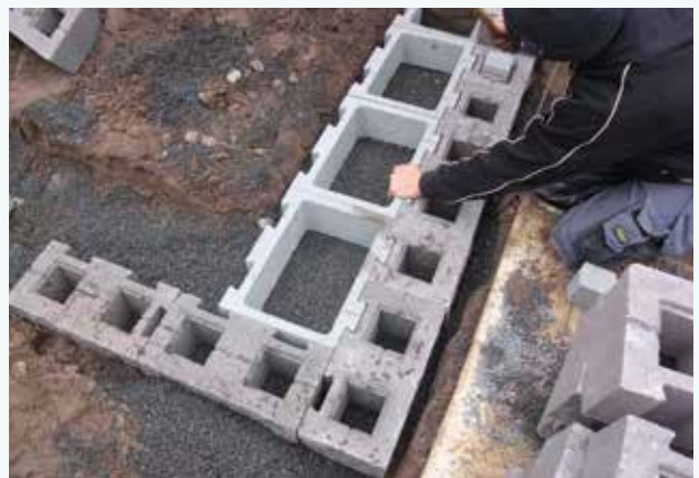
Plaatsen counterblok achter G-blok.
