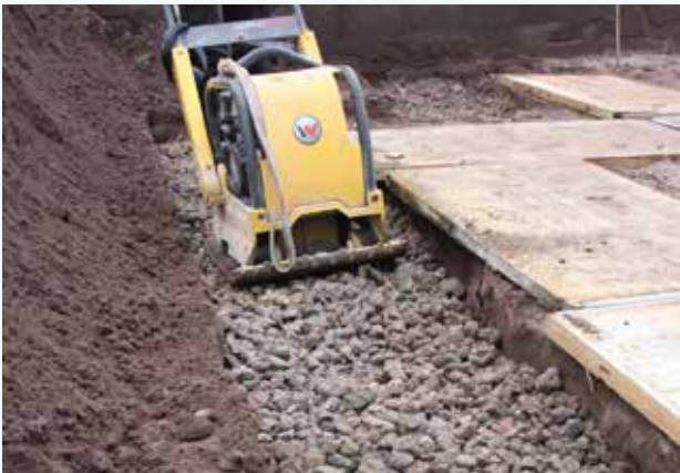
Aanvullen met gerecycleerd beton 10/40 tot 20/40 en afrillen.
