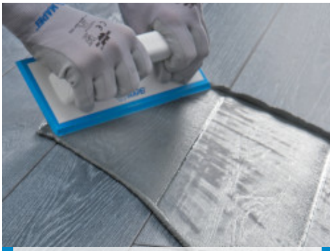
Ultracolor Plus met behulp van een voegrubber aanbrengen op porseleinen vloertegels met hout-effect
