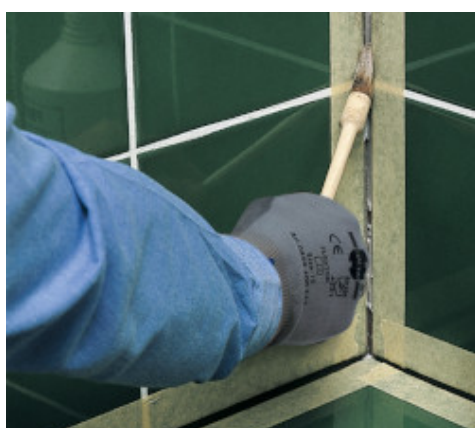
Aanbrengen van Primer FD
