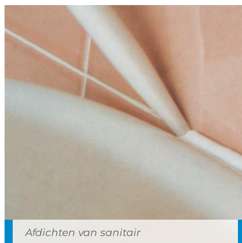
Aanbrengen van Mapesil AC
