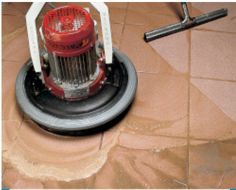
Met een rubber vloertrekker of poetsmachine afwerken van een porseleinen tegelvloer
